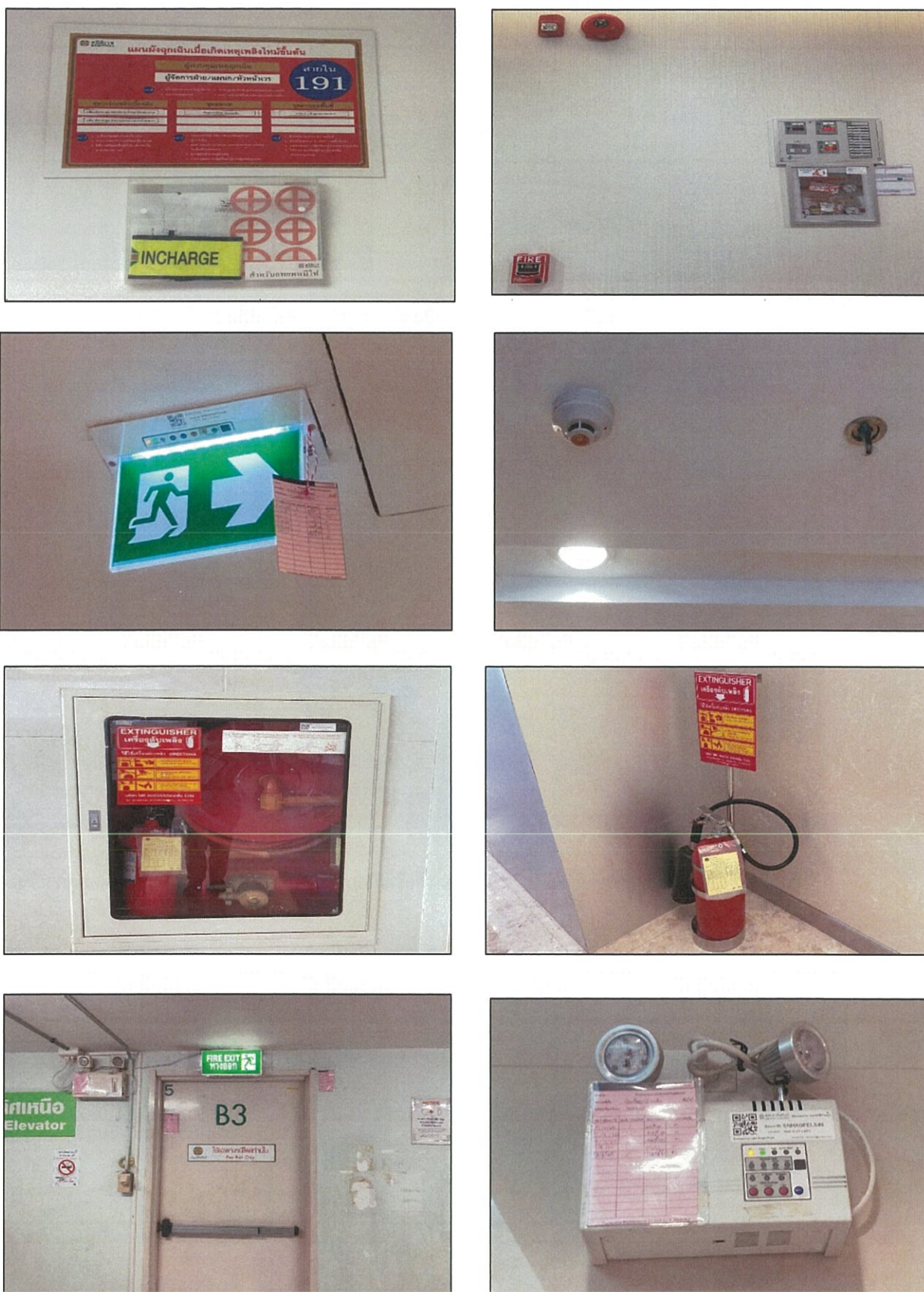
รูปที่ 2.2-14 ระบบป้องกันและแจ้งเตือนอัคคีภัยของโครงการ
